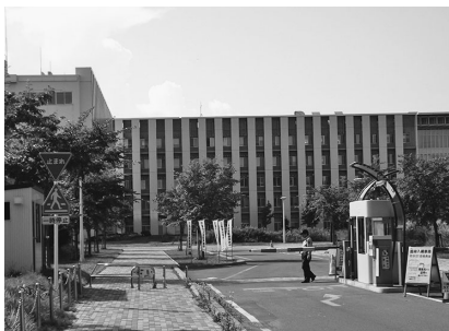
写真7 新設された北20条東門
