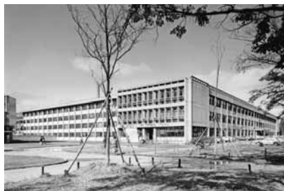
写真9 南東から見た教養部校舎
