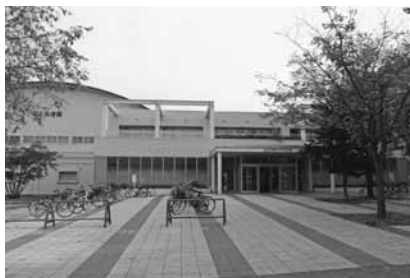
写真11 現在の体育館入口付近
