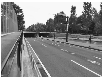
写真9 環状通エルムトンネル西側
