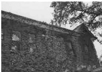
写真10 解体直前の柴田記念館
