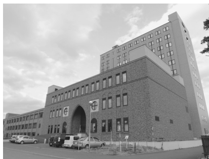
写真7 理学部六号館の低層棟と高層棟
