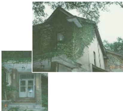
解体直前の柴田記念館（旧金属化学研究室） 平成6年（1994）3月15日
